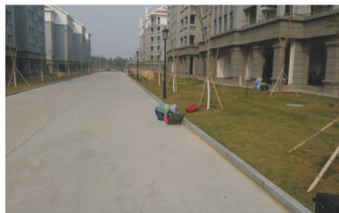
(图为清理漏水井的沙土、树叶)
