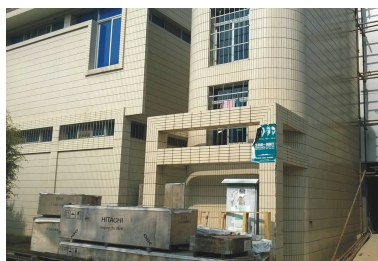
安装中的东苑餐厅电梯
