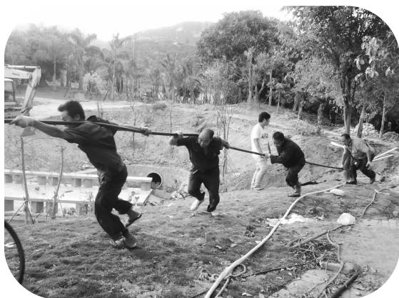
2013年10月19日下午,水电维修部员工,齐心协力、牵拉布设水上音乐广场电源电缆
