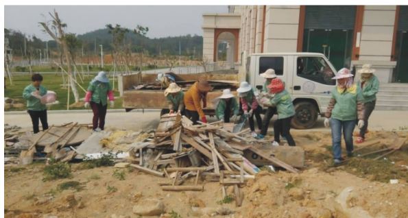
清理、清运、填埋二期食堂南侧拆迁工地的垃圾
