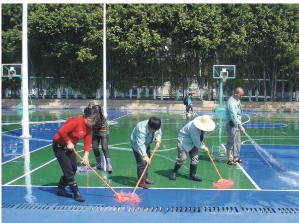
盖板进行疏通。由于沟盖板与塑胶层及水泥板紧密结合在一起，打开难度较大，需先用刀片切割开，然后用锤子敲打震动，再撬开清掏
